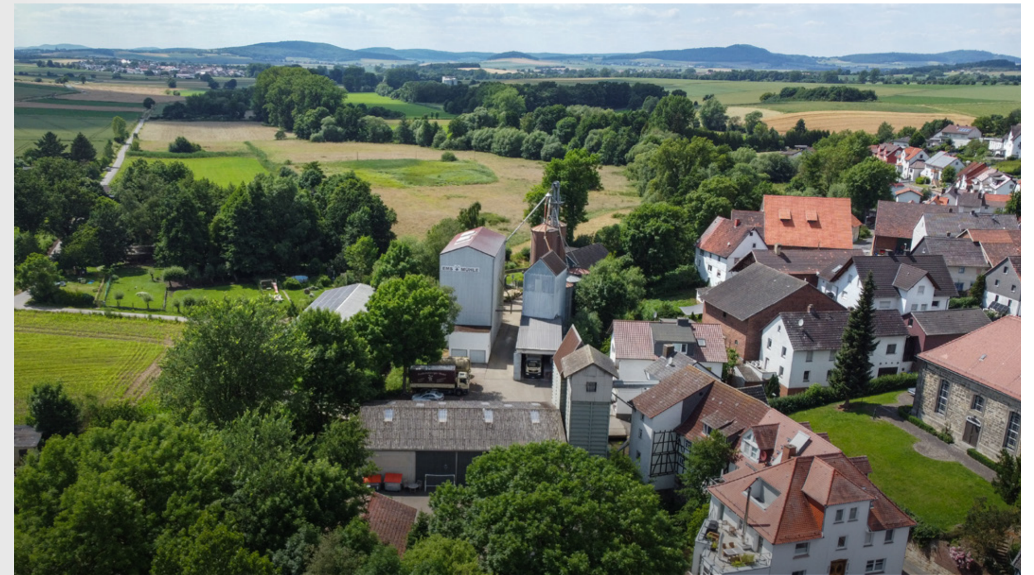
Die Emsmühle in Gudensberg
